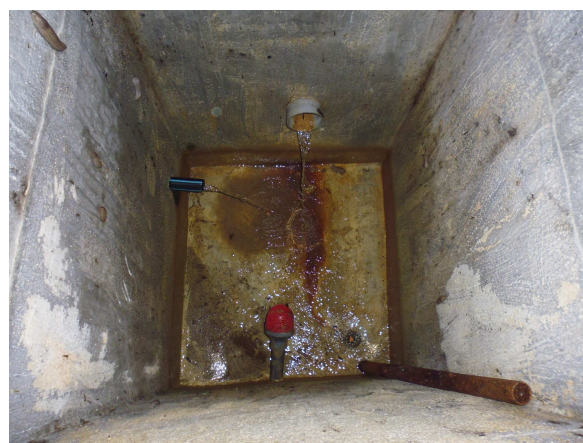
Figure 18 : Ouvrage de réunion des deux drains – Sources du Planeuil.
