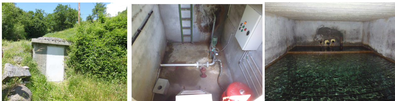
Figure 21 : Station de pompage de Jussel.
