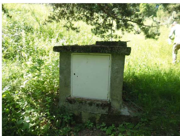
Figure 18 : Ouvrage de réunion des deux drains – Sources du Planeuil.
