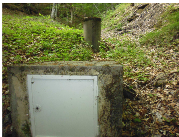
Figure 13 : Captage de Combouisse .
