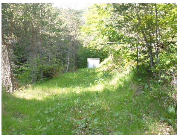
Figure 12 : Captage des Coste Rolande .
