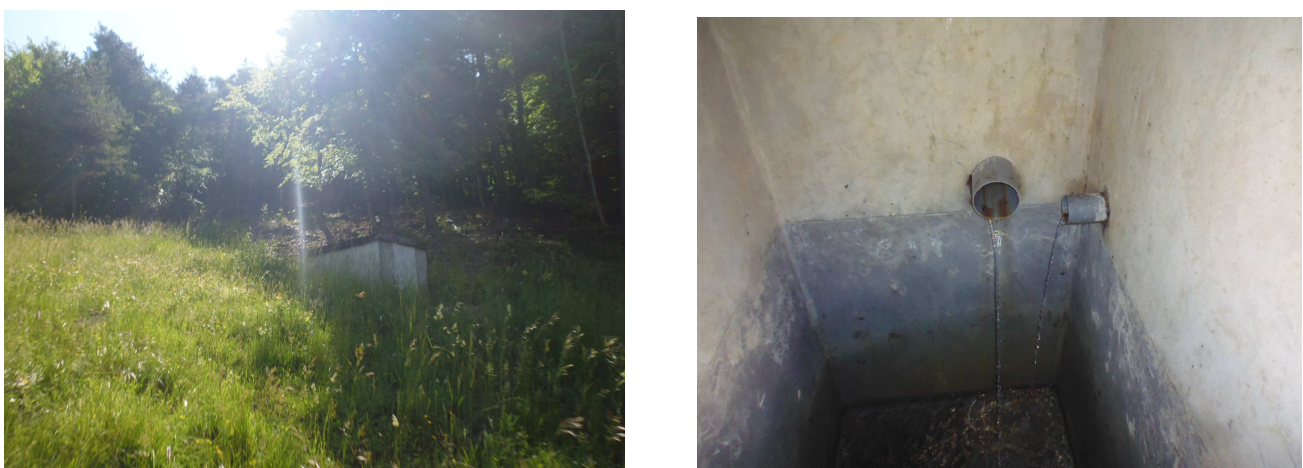
Figure 10 : Captage de Brasc .
